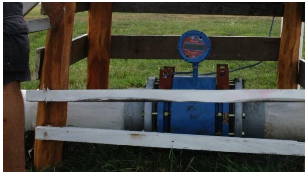
Figura 182. Infraestructura para el riego por gravedad en la parcela “El Junco”, caudalímetro volumétrico electromagnético y medidor de avance en entrada de la parcela piloto.
