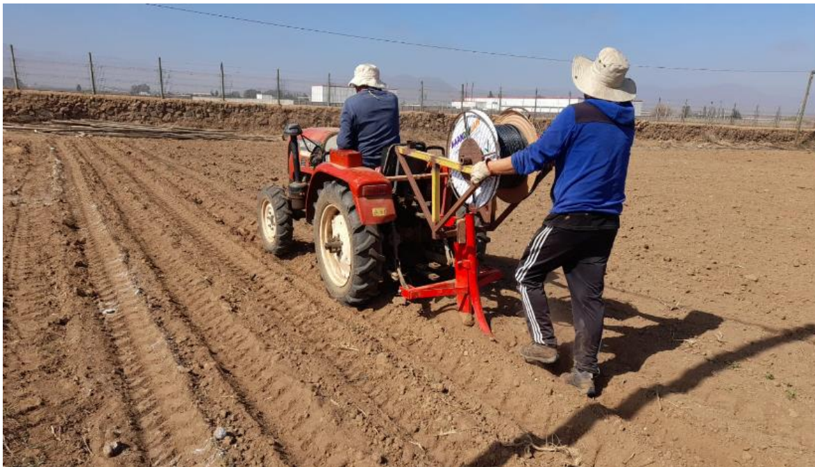
Figura 139. Instalación de línea de riego subterráneo.
