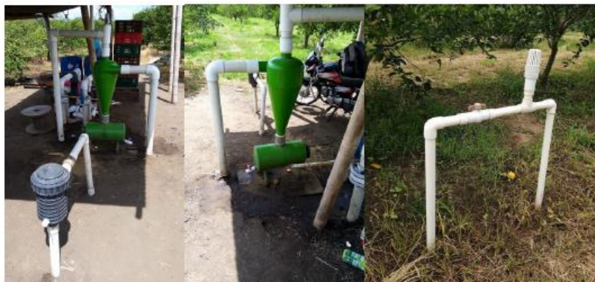
Figura 149. Estación de filtrado y montaje de válvulas de módulo. Foto: Marysol Cano.
