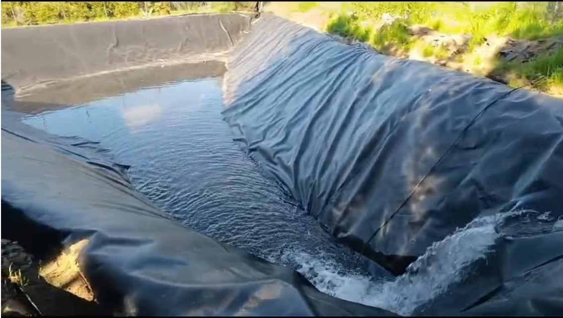
Figura 141. Inicio de llenado del estanque para revisión de fugas.
