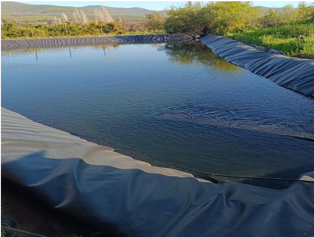
Figura 141. Inicio de llenado del estanque para revisión de fugas.
