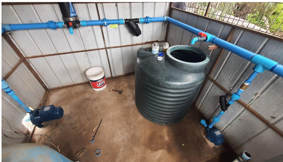
Figura 143. Elementos instalados para el control del riego e inyección del fertilizante al huerto del C.E. Choapa de INIA en Illapel.
